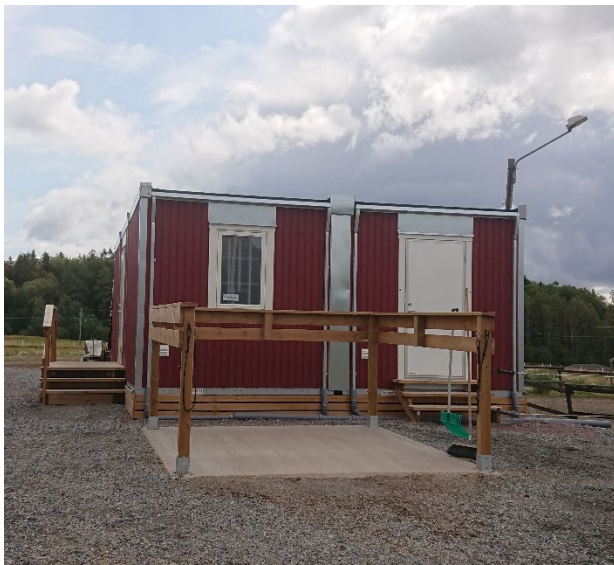
På Grums RK har man byggt nya omklädningsrum med duschar för medlemmarna och en spolspilt för hästarna.
